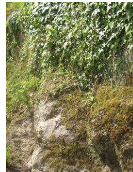
Roche au pied d'un mur - La Gozière
