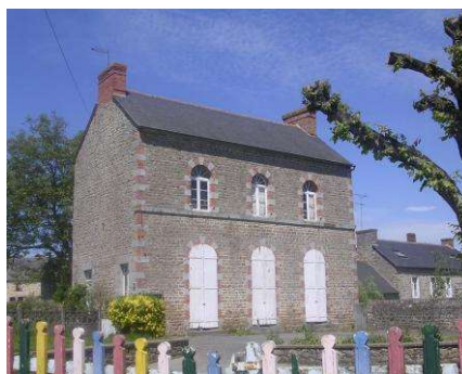
Bâtiment qui accueille toujours l'école primaire de la commune.
