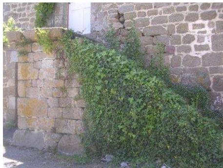
Escalier extérieur sur la façade principale
