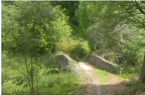
Pont dans son environnement resté Sauvage - La Servais
