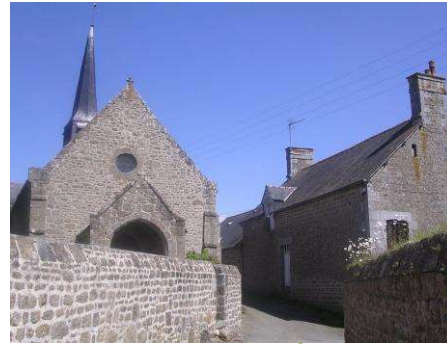
Ruelle menant à l'enclos enserrée de muret
